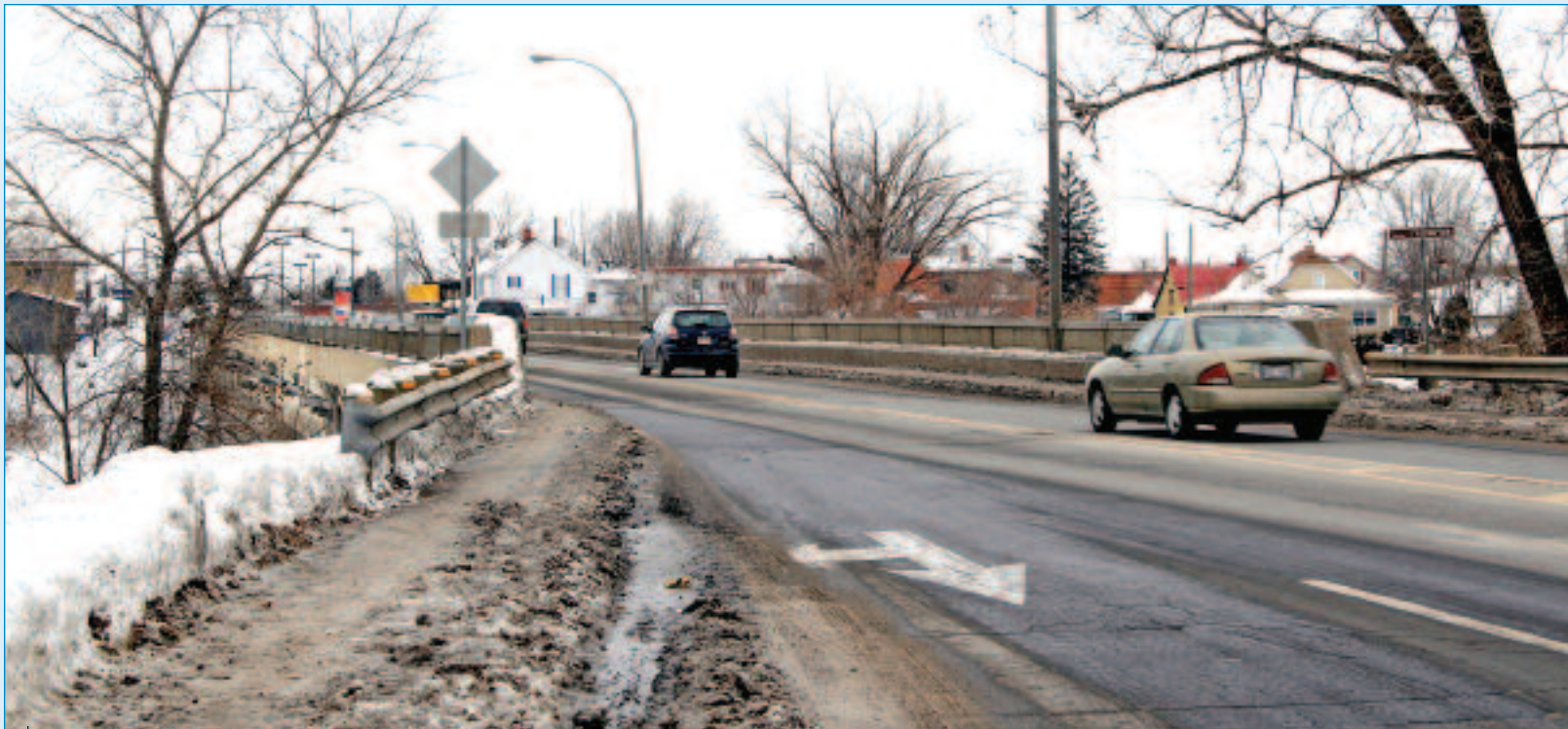
La Ville de Repentigny procédera à la reconfiguration des approches du pont Rivest, tant du côté du secteur de Repentigny que du côté du secteur Le Gardeur.
